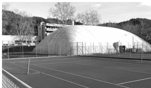
Seit 2017: 2-Feld-Traglufthalle der FT über die Wintersaison auf unseren Plätzen 5 und 6
